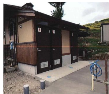
増設・水洗化した姪石苑のトイレ R元.10
