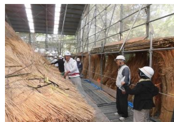
重要文化財「智識寺大御堂」の修理工事見学会の様子 H29.5
