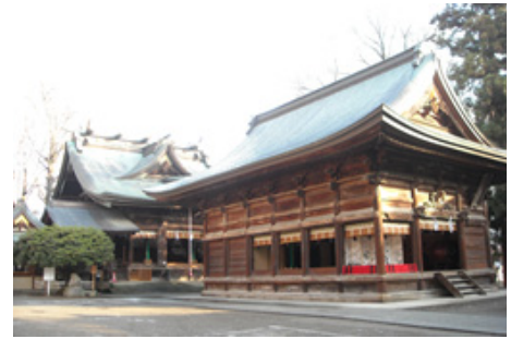
武水別神社本殿・拝殿
