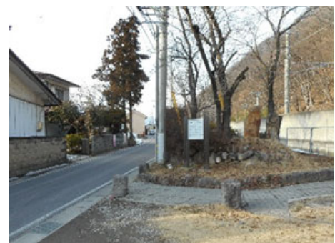
寂蒔水除土堤
