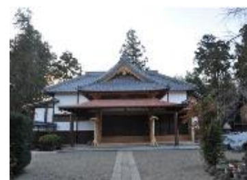
修理後の松田家齋館
