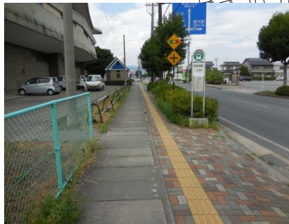
現況写真(西側歩道)
