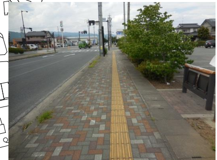
現況写真(東側歩道)
