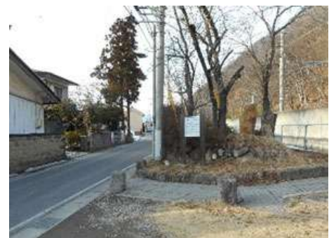
寂蒔水除土堤
