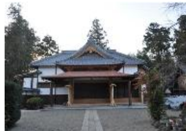
修理後の松田家齋館
