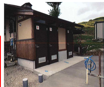
増設・水洗化した姪石苑のトイレ R元.10
