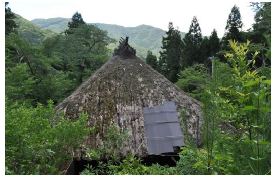
観龍寺本堂(修理後)
