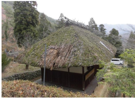
観龍寺本堂(修理前)
