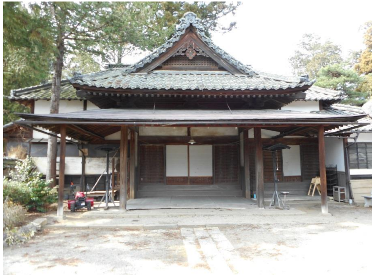
修理前(火災前)
