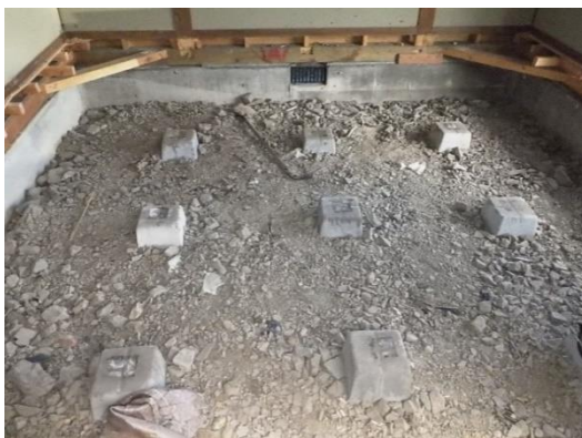
改修前(板の間の板を剥いだ状態) R2.9
