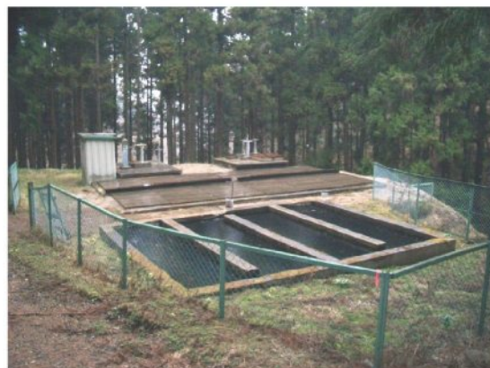
大田原浄水場：ろ過池内部
