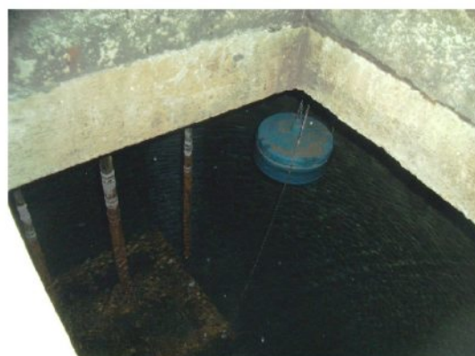
大田原浄水場：ろ過池内部
