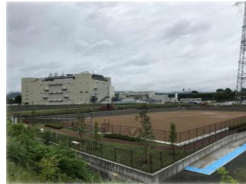
雨水調整池の例(雨宮産業団地)
