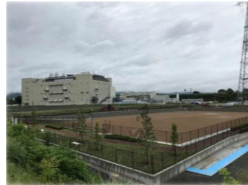
雨水調整池の例(雨宮産業団地)
