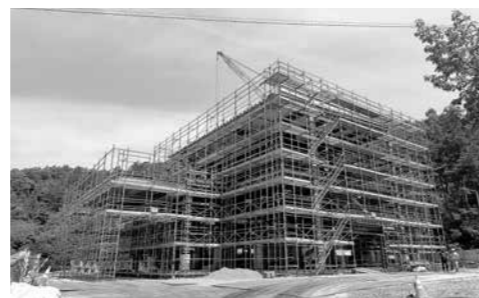
▲新リサイクルセンター工事状況
