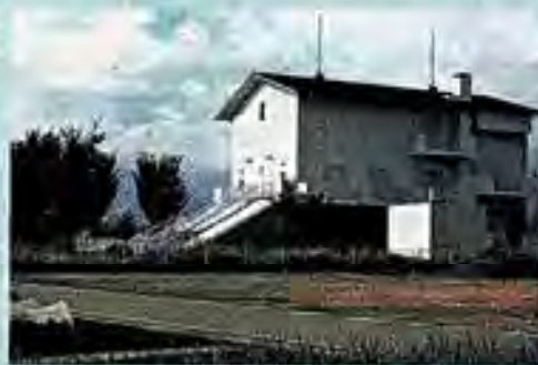
尾米川排水ポンプ場
