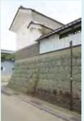
石垣の高さは3メートル、その石積みは大変美しい
