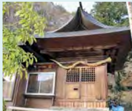
銅板葺きの屋根の本殿
