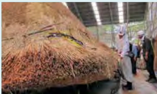
葺き替え作業の様子
