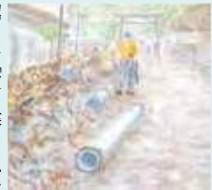
上水道布設工事の写真を絵で再現（三村乃史子作、八幡公民館所蔵）
