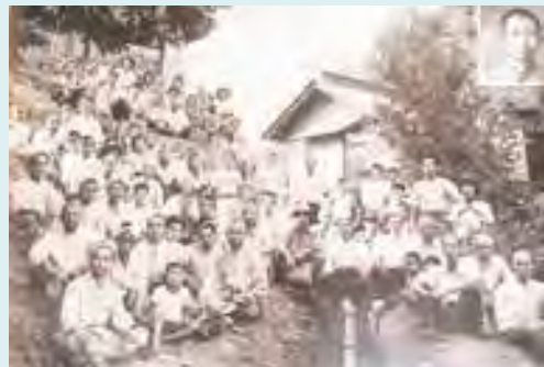
峯区水道管布設工事中にパチリ
