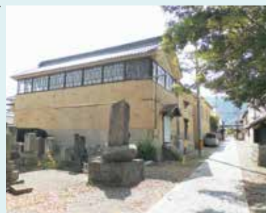
町屋敷東蔵小路の土蔵群①
