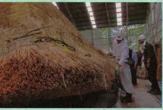
葺き替え作業の様子
