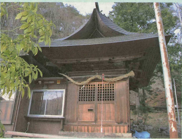
銅板葺きの屋根の本殿
