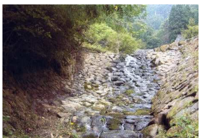
13 桂沢川石堰堤
