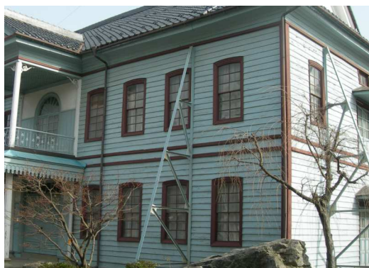
屋代小学校旧本館の鋼鉄支え枠
