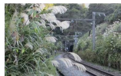
10 冠着トンネル
