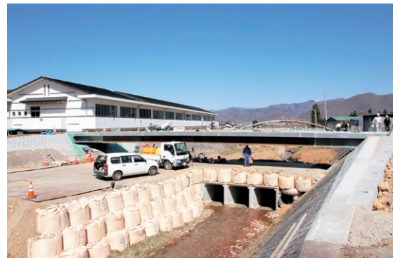
▲更埴西中の南西に建設中の「希望橋」(4月16日撮影)
