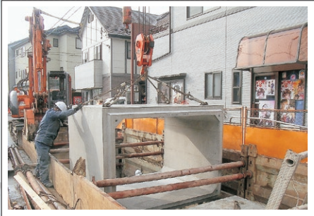
▶27年8月 温泉排水区雨水渠整備（第1期）工事完了（上山田地区）
