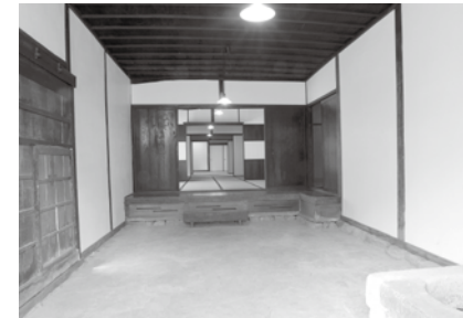
▲玄関の土間を入ると、とりつぎの間・なかの間・客間・座敷と続いています
