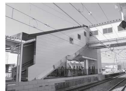
▲改札北側に設置されたエレベーターと新こ線橋
