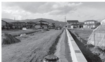
▲残り220mの新設道路工事を進めています
