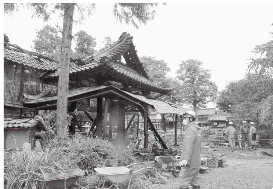
▲焼失した斎館(写真手前)と主屋(写真奥) 9月7日撮影
