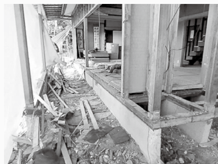
▲改修が進む空き家
