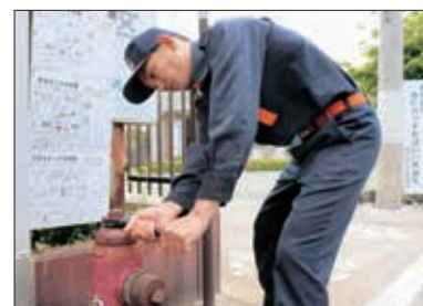
▲消火栓の点検を行なう山崎さん
