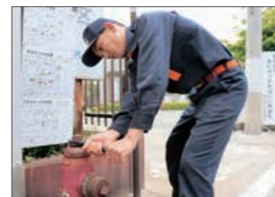
▲消火栓の点検を行なう山崎さん
