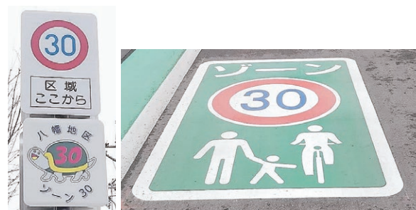
▲ゾーン30地区の入口には道路標識、路面標識を設置
