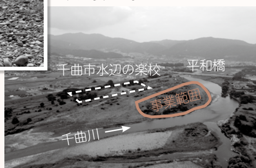
▲平成28年度施工箇所(千曲市八幡地先)
