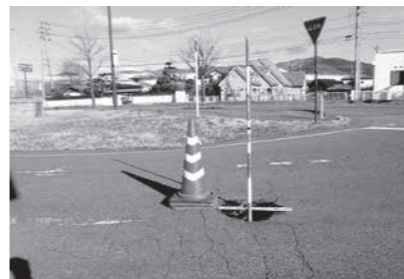
▲陥没した道路
