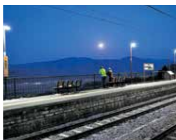
▲レンガが残る姨捨駅のホーム
