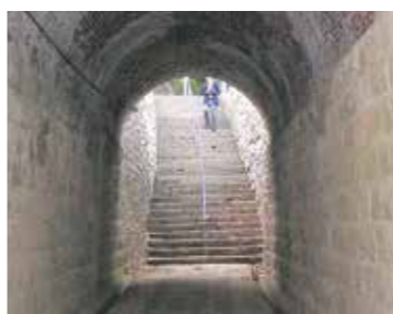
▲龍洞院架道橋
