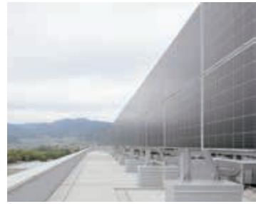
▲市役所屋上の太陽光パネル
