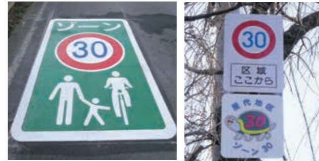
▲ゾーン30地区の入口には路面表示、道路標識を設置
