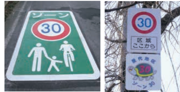
▲ゾーン30地区の入口には路面表示、道路標識を設置
