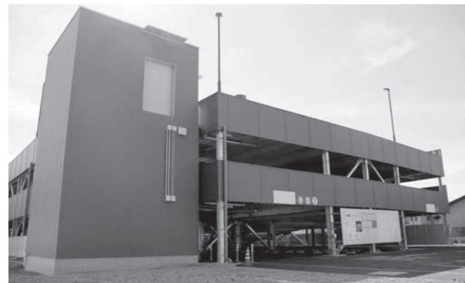
▲完成間近な千曲市立体駐車場
