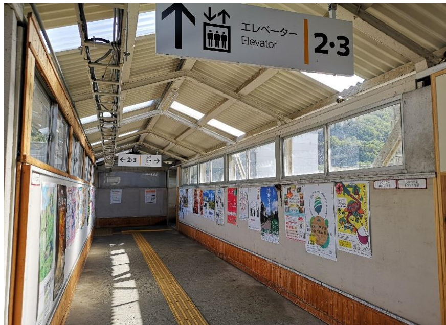
【一部（屋根）施工後】
