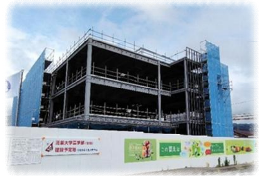
工事写真（6月4日撮影）
