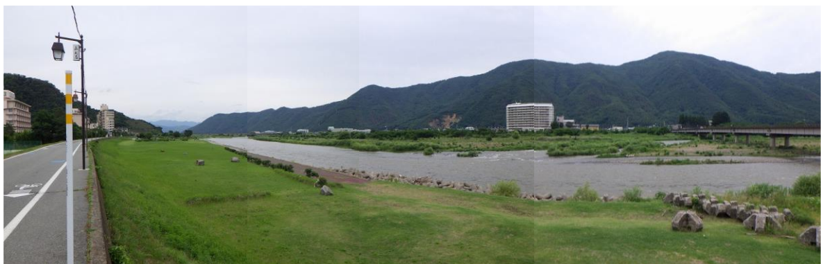
戸倉上山田温泉側（左岸側）の堤防道路からみた河川景観
