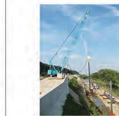
浸透対策工法の実施例 (川表法尻に遮水矢板を打設)
