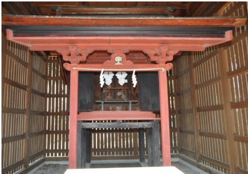
室町時代の社殿が覆屋内に安置
