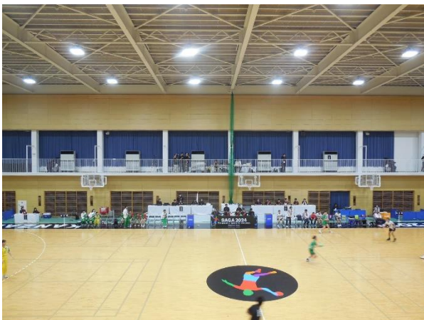
暑さ対策として2階ギャラリーに設置されたエアコン(仮設)
