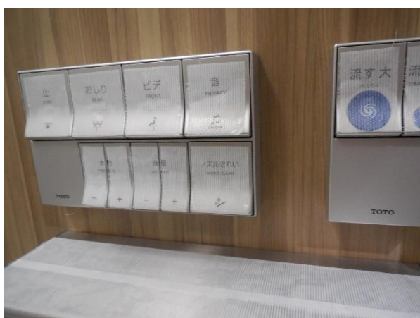
松やに対策(トイレのボタン等の養生)
