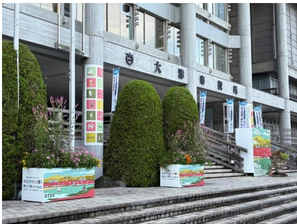
▲庁舎出入口のPRサイン等の様子 (滋賀県大津市)
